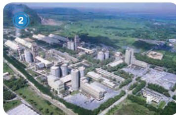
KOMPLEKS PABRIK PALIMANAN Cirebon, Jawa Barat
